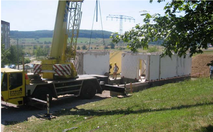
Montage des Rohbau
