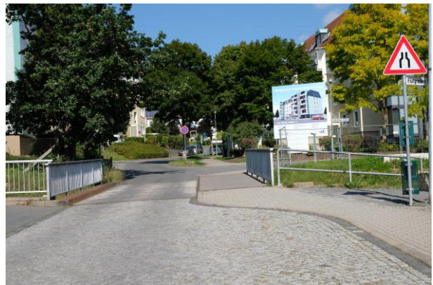
Engstelle, unzureichende Fuß- und Radweganbindung
