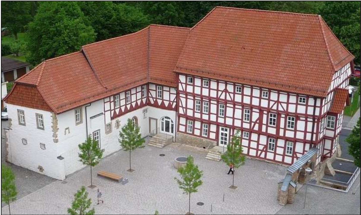
Abbildung 2: Rentamt (nach Sanierung)
