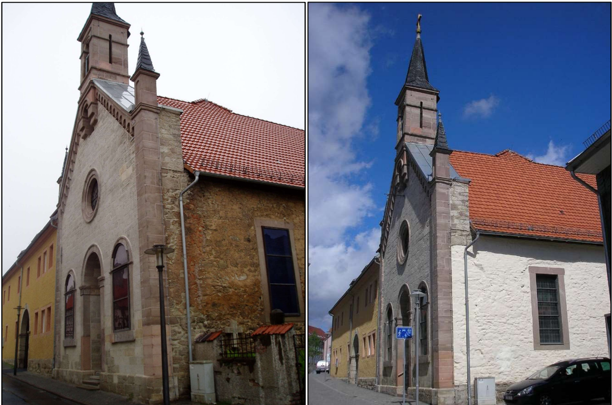
Abbildung 3: Sanierung der ev. Kirche St. Peter und Paul (vor und nach Sanierung)
