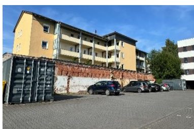
2,5 m hohe Stützmauer (+2,5m) südlich des Geltungsbereiches, mit Blick auf das GEWOG-Gebäude
