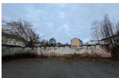
2,5 m hohe mit ca. +1,00 Geländesprung an der westlichen Grenze, mit Blick auf GEWOG Gelände
