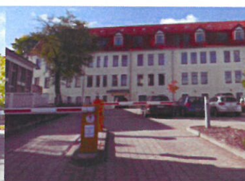
Sparkasse viergeschossig Bankgebäude mit Ärzten
