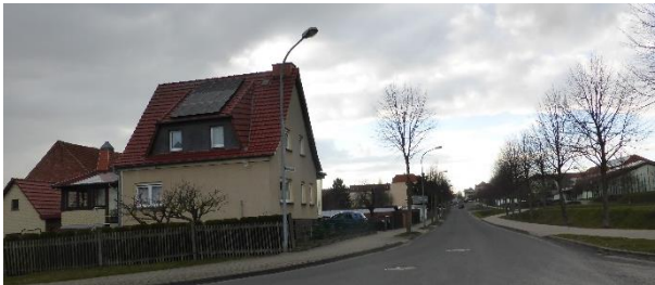
Südlich gelegene Mischbauflächen mit Wohnhaus
