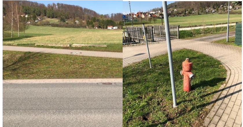
Unterflurhydrant in Elisabethstraße und Oberflurhydrant i im Kreuzungsbereich Zum Stadion
