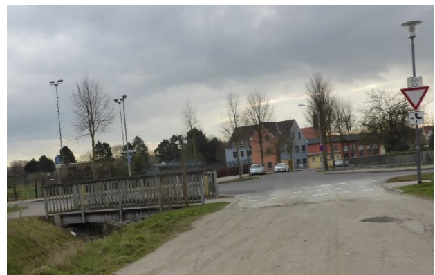
Der östliche Graben am Weg führt ebenfalls zur Wipper und erlaubt auch eine zu genehmigende Einleitung von Oberflächenwasser aus der Rückhaltung (5 l/s/ha).
