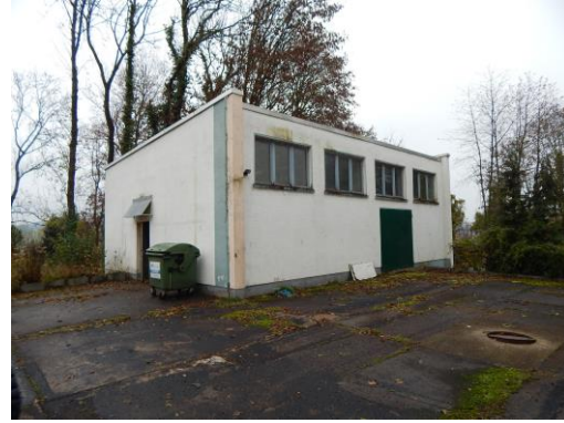
Abbildung 15 Heizhaus, Lage zwischen Hotel und Bettenhaus , Blick nach Süden
