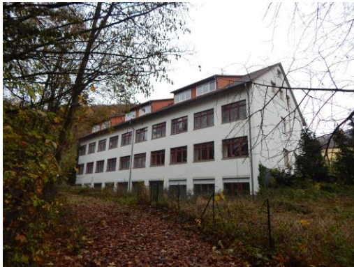
Abbildung 8 Bettenhaus, Blick Richtung Norden
