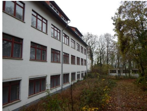
Abbildung 9 Bettenhaus, Blick nach Süden, Nebenanlage
