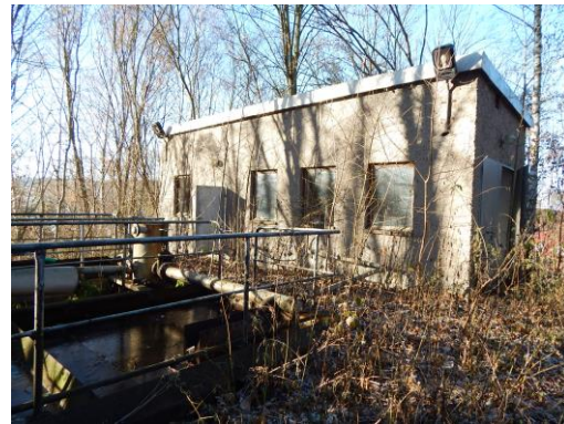
Abbildung 17 Teilbereich Kläranlage, südwestlicher Gelände-komplex
