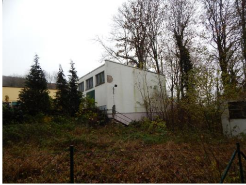
Abbildung 14 Heizhaus, Lage zwischen Hotel und Bettenhaus
