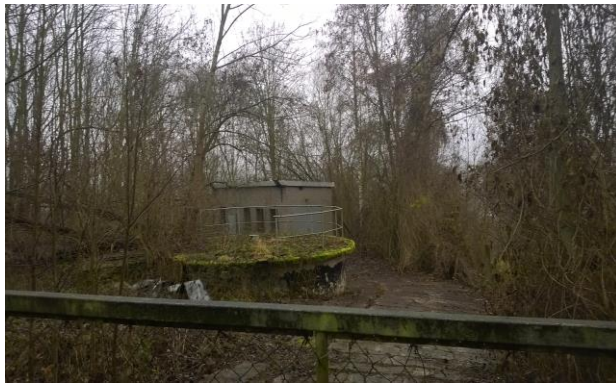
Abbildung 16 Teilbereich Kläranlage, südwestlicher Gelände-komplex
