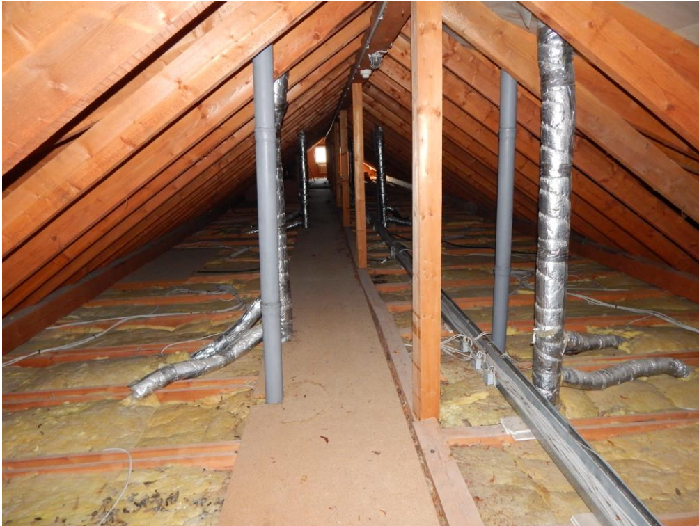
Dachboden Hauptgebäude (ehemaliges Hotel)
