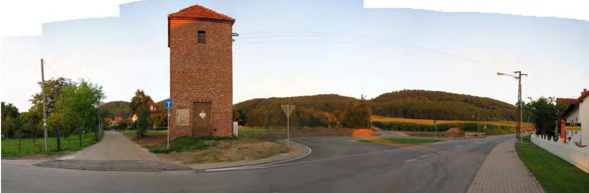
Blick 03 in Richtung der Strasse „Hinter den Höfen“ auf das Plangebiet
