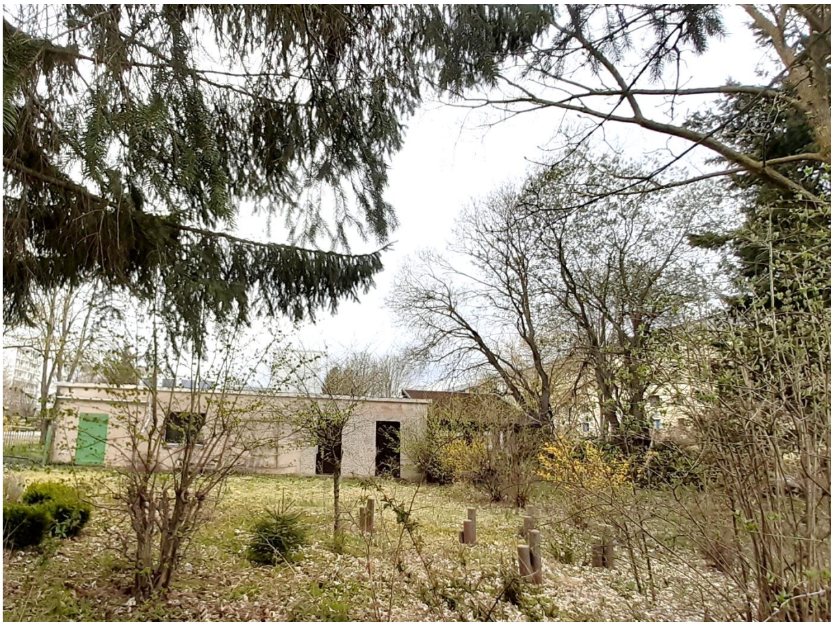
Abb. 8: Altes Gebäude im eingezäunten Teilbereich (mittig, Nord)
