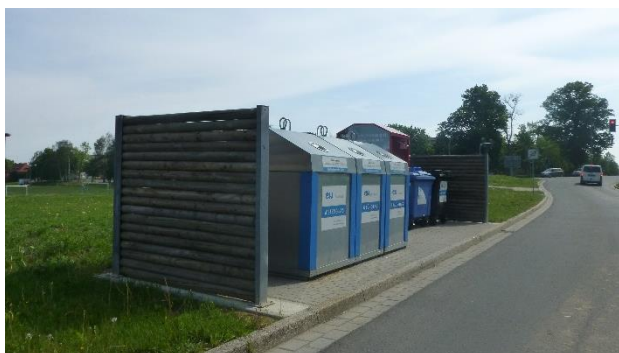
Die RC Container befinden sich südlich vom Geltungsbereich
