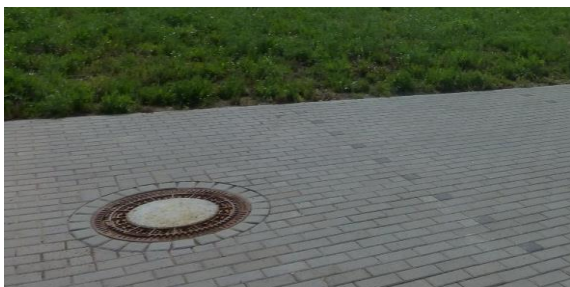
Hausanschlüsse und andere Anschlusschächte befinden sich im Ulmenweg und sollen Verwendung finden
