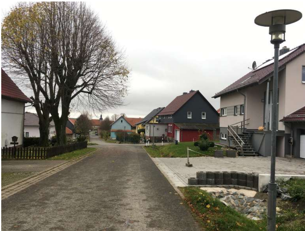
Abb. 6: Plangebiet B-Plan Nr. 48 „In den Birken“, entlang der Straße In den Birken (Flurstück 61, Blick in Richtung Dorfanger)
