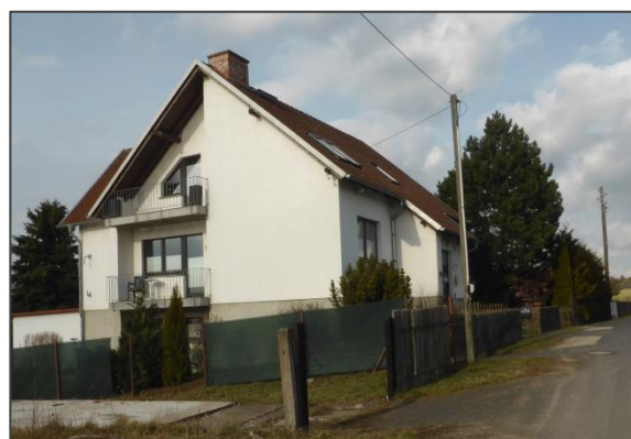
Obenstehendes Foto zeigt die unmittelbare Nachbarbebauung in westlicher Richtung.
