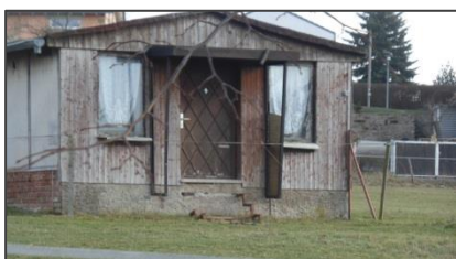
Geplanter Rückbau der vorhandenen Baracke auf dem Grundstück der neuen Erschließungsanlage
