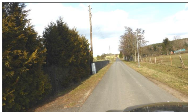
Der „Bodenweg“ sollte als Sackgasse beschildert werden, da dann ein landwirtschaftlicher Weg folgt.
