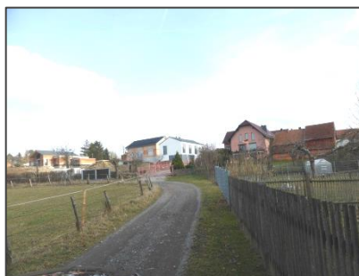
Blick auf die neu entstehende Klientenbebauung, welche bis Ende 2019 bebaut sein wird.
