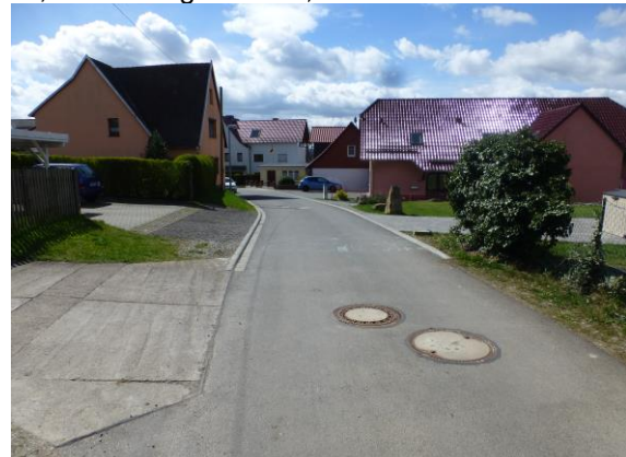
Übergang Bestand zur auszubauenden Straße
