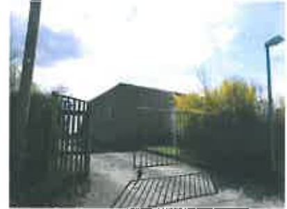
Benachbartes Gebäude als Flachbau, derzeit ohne Nutzung
