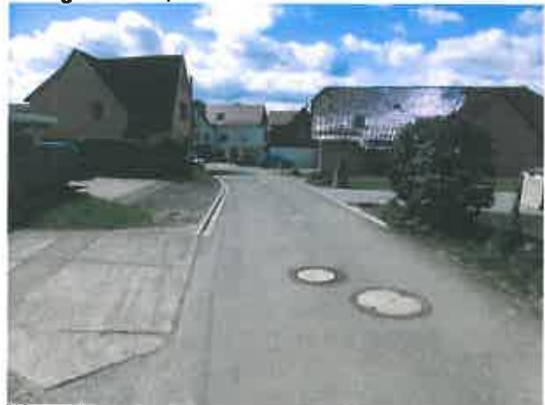
Übergang Bestand zur auszubauenden Straße
