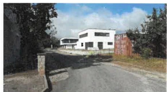
Abb. 6: Erschließungsweg für das Baugebiet „Peggy Hunold, Schulstraße“ in westliche Richtung
