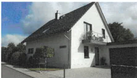
Abb. 11: Wohnhaus Bei der Ziegelei Nr. 6
