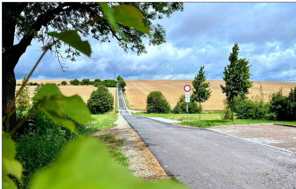
Direkt am Breitenhölzer Friedhof entstanden im Zuge der Baumaßnahme auch mehrere neue Parkplätze, ein Fußweg sowie ein Stellplatz für eine Biotonne.
