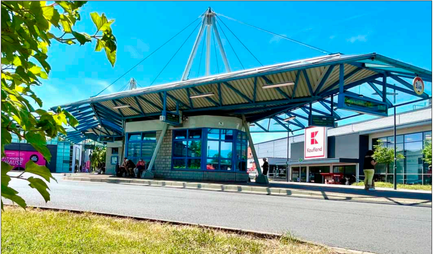
Der Leinefelder Busbahnhof macht zwar äußerlich noch einen guten Eindruck, ist aber sanierungsbedürftig. Foto: René Weißbach
