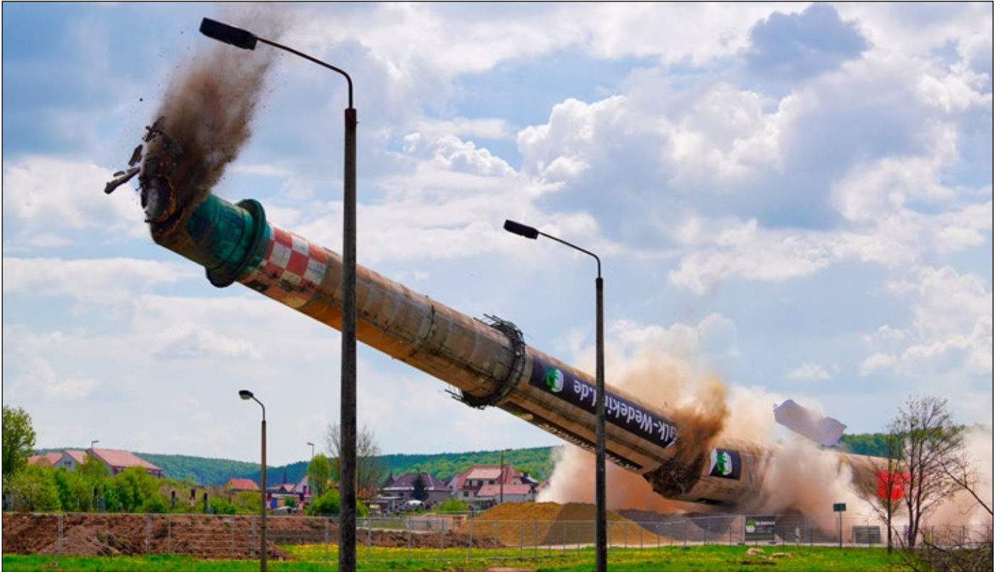
Mit einem lauten Knall versank der 99 Meter hohe Beton-Schlot am 7. Mai in einer großen Rauchwolke.
