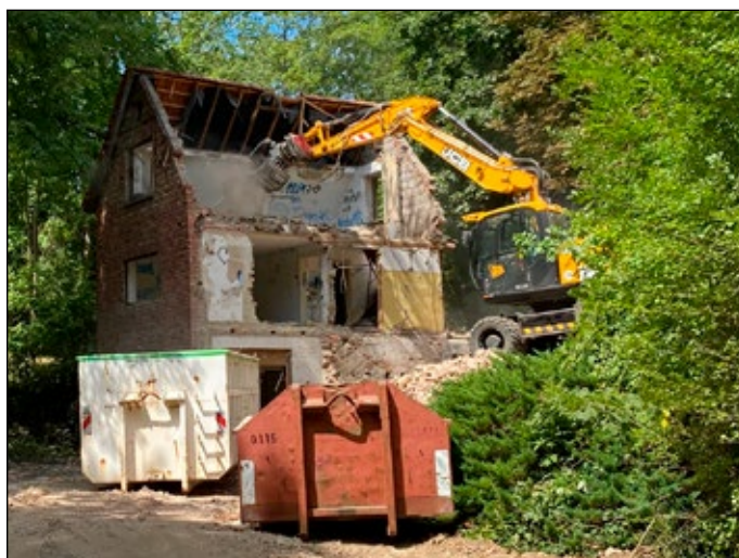
Das ehemalige Gartenhaus von Dr. Tüffers wurde vollständig abgerissen. Hier entsteht ein neues Gebäude. Foto: Daniela Poppe
