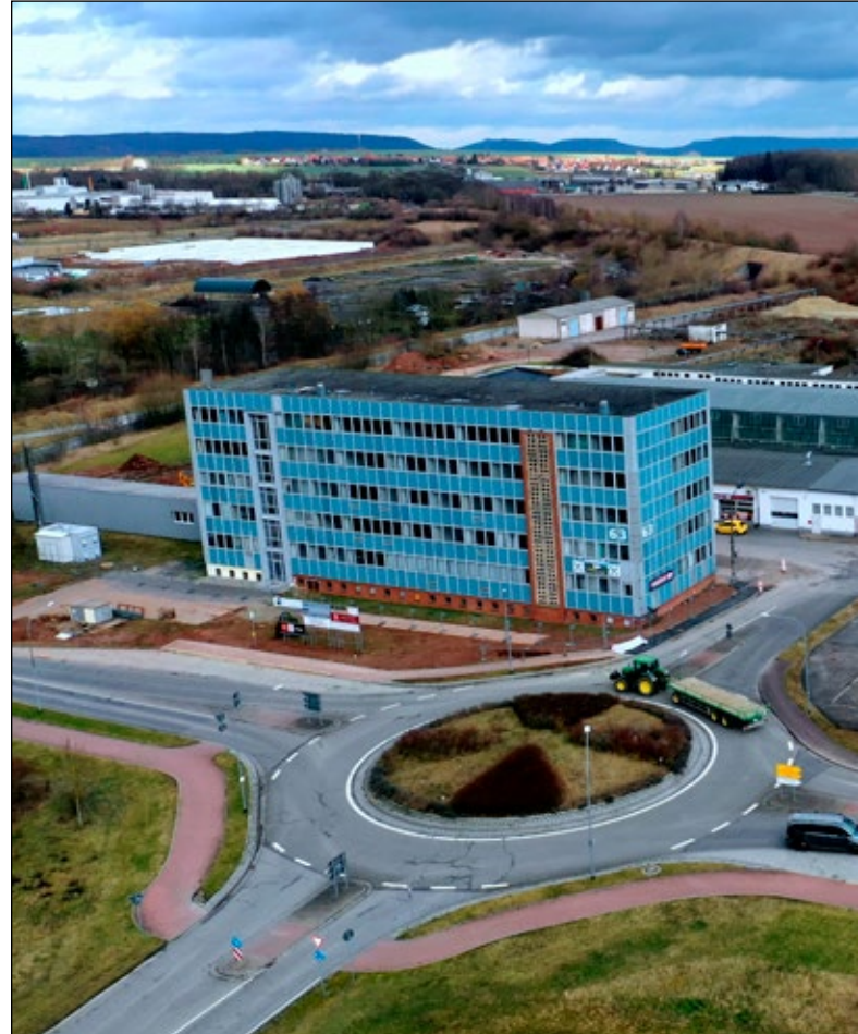
Eines der letzten Luftbilder vom alten Milchhof, bevor hier die Abrissarbeiten beginnen.
