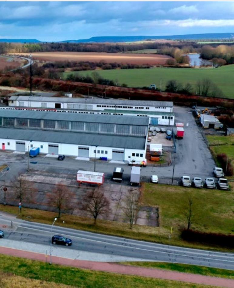
Arbeiten begonnen haben.
