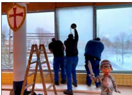
Mit 430.000 Euro schlugen bisher die Sanierungsarbeiten im Leinebad zu Buche.
