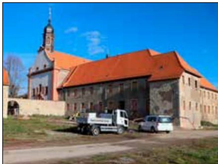
Das Kloster in Worbis hat bessere Jahre vor sich. Die Arbeiten gehen weiter.
