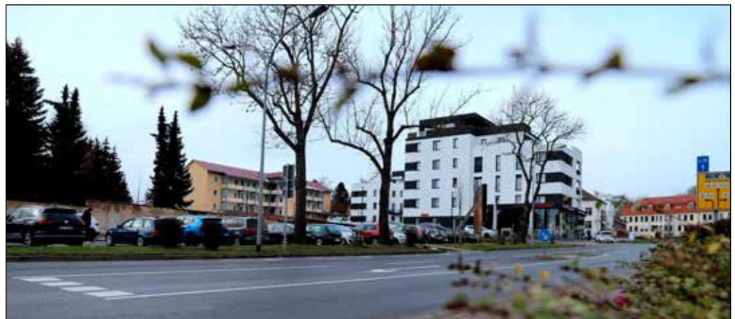
Direkt neben der einstigen Polizeistation in Worbis soll ein weiteres Wohn- und Geschäftshaus inklusive Parkdeck entstehen. Hierzu ermittelt die Stadt jetzt den Bedarf. Foto: René Weißbach
