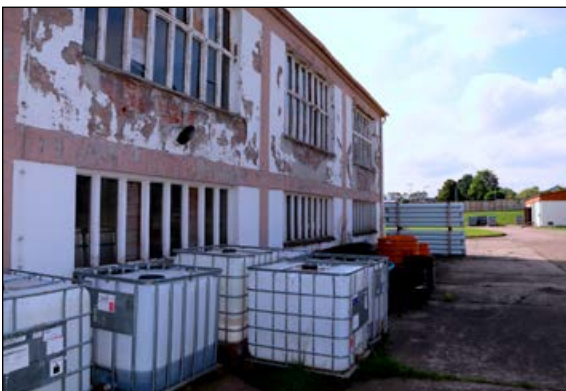
An einem Luftbild zeigt Oliver Thiele die geplanten Maßnahmen (oben). Die alte Farbwasserbehandlungsanlage der Spinne wird abgerissen. Fotos: R. Weißbach
