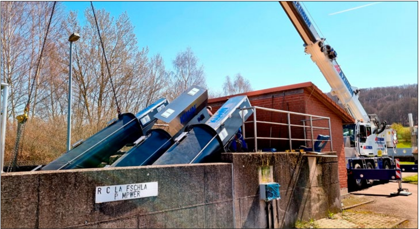
Nur mit Hilfe eines großen Schwerlastkrans war es möglich, die tonnenschweren Einzelteile zu bewegen.
