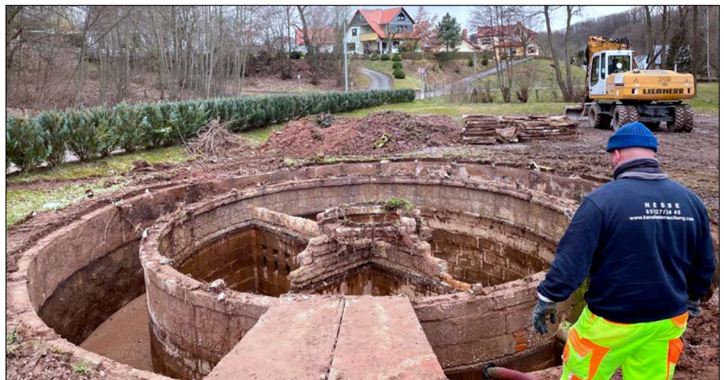
Die Anlage im Hundeshagener Freibad war in die Jahre gekommen und musste komplett erneuert werden. Jetzt sorgt eine moderne Sammelgrube für bessere Abwasserqualität. Foto: Simone Haase
