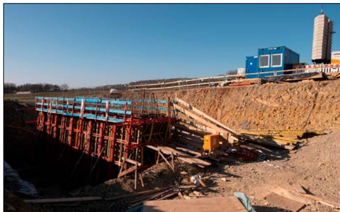
Dieses ist eines von vier Brückenbauwerken und entsteht an der südlichen Peripherie der Leinestadt.
