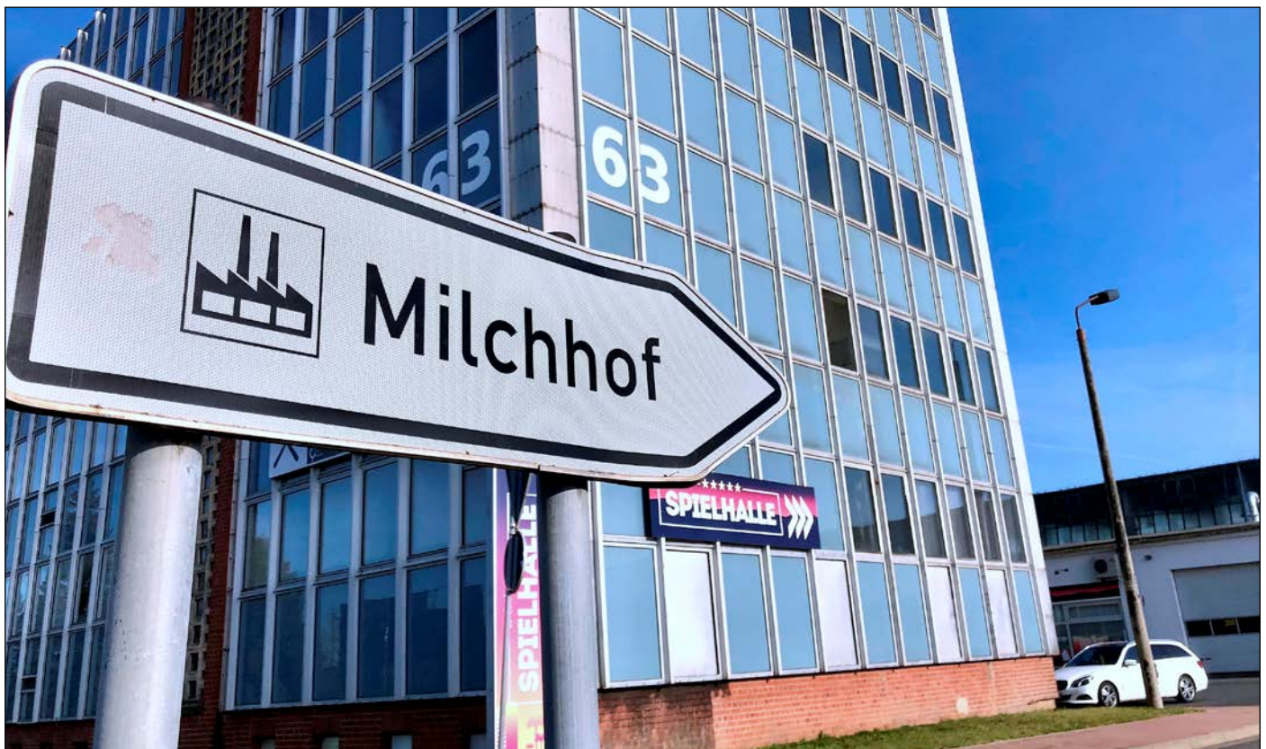
Das alte Hochhaus am früheren Milchhof hat ausgedient. Es wird mit hoher Förderung abgerissen.
