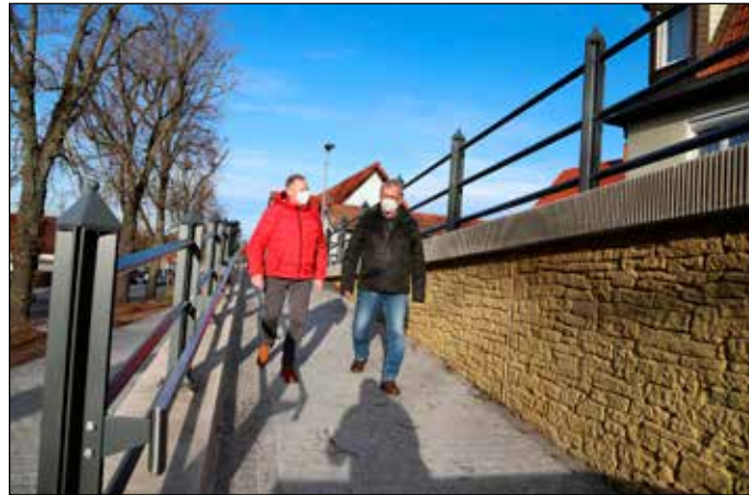
Ortsbürgermeister Dirk Moll (links) und Michael Barthel vom Bauamt inspizierten die Arbeiten an der Mühlhäuser Chaussee. Die markante Mauer soll später beleuchtet werden. Foto: R. Weißbach
