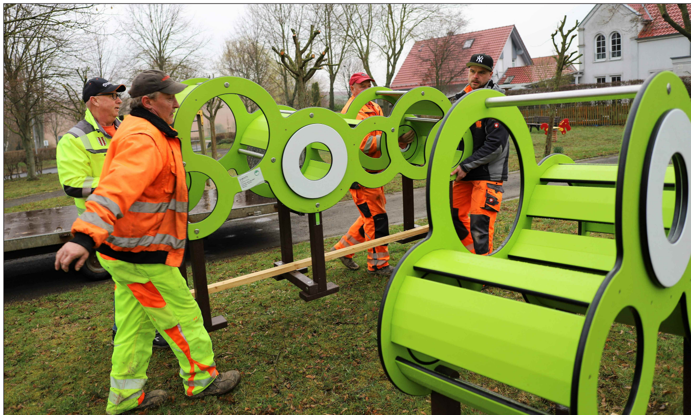
Mitarbeiter des Bauhofes brachten die neuen Spielgeräte im Breitenhölzer Unterdorf an ihren Platz. Sobald sie fest im Boden verankert und offiziell freigegeben sind, stehen sie den Kindern zum Toben zur Verfügung. Foto: René Weißbach
