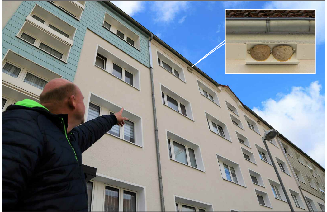
SWG-Mitarbeiter Matthias Ahrendt vor der renovierten Fassade des Wohnblocks in der Lessingstraße. Die Nisthilfen wurden bei der Lebenshilfe in Leinefelde hergestellt. Fotos: René Weißbach
