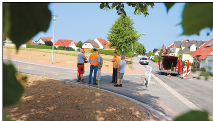
Martin Lauterbach (Erschließungsträger) inspiziert mit Vertretern der Baufirmen und des städtischen Bauamtes die Straße „Am Abendrasen“ während der Abnahme. Foto: René Weißbach
