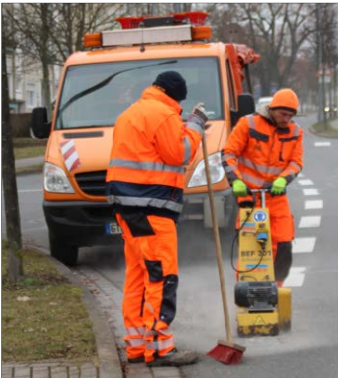
Mitarbeiter des Bauhofes fräsen überflüssig gewordene Markierungen von der Elisabethstraße. Foto: Stella-Marie Klaus
