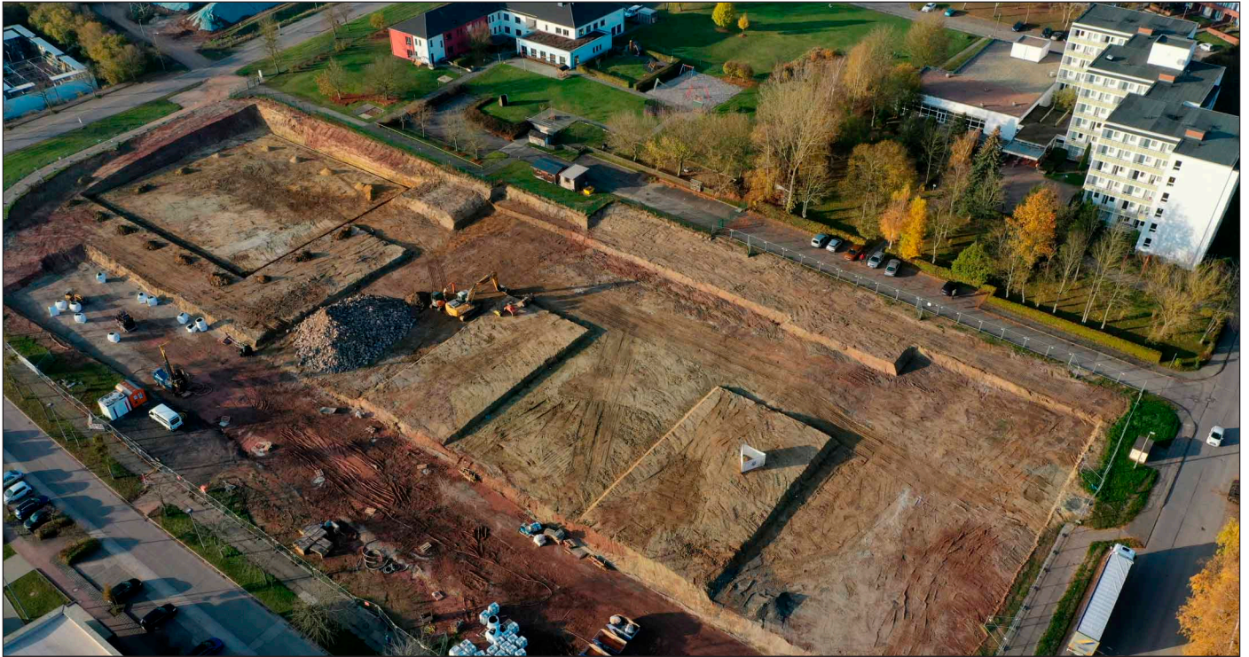
Deutlich sichtbar sind die Fortschritte auf der Baustelle des neuen Schulcampus in der Leinefelder Südstadt. Foto: K. Schwanengel
